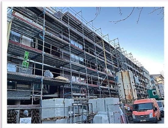
Straßenansicht zweiter Bauabschnitt
