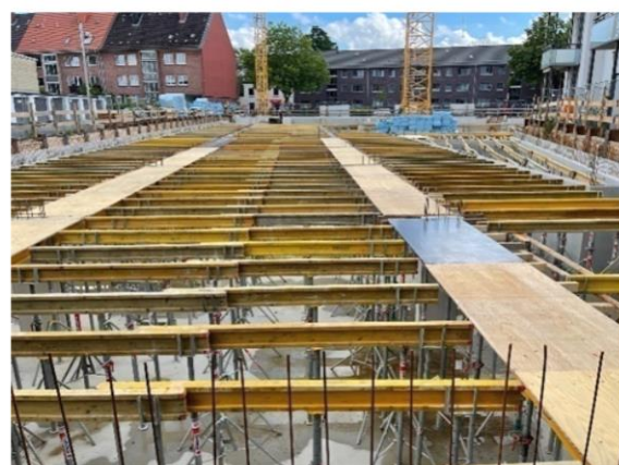
Schalung ist bereit für die Deckenplatten.
