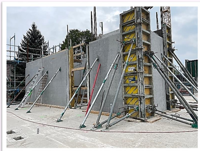
Montierte Halbfertigteile 2. OG für Aufzugsschacht und Treppenhaus
