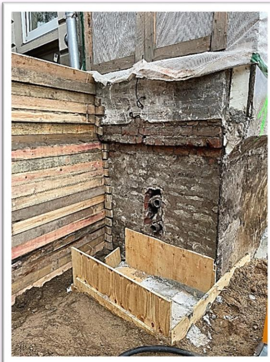
Unterfangung des Giebels Behnkenkammer 6
