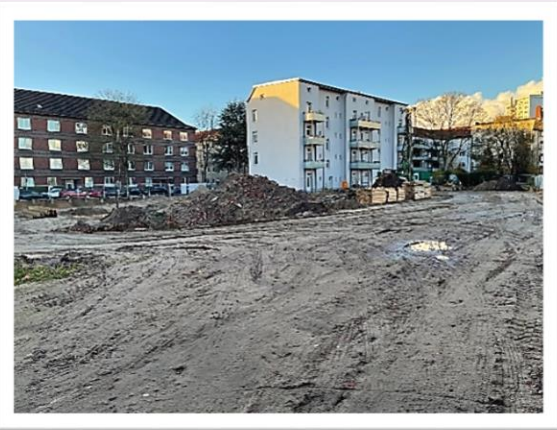
Herstellung der Baugrube
