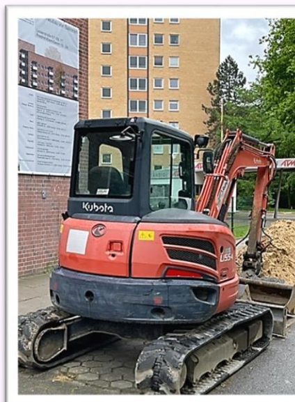
Modernisierung und Neubau von Balkonen im Friedrich-Ebert-Damm/Lesserstraße
