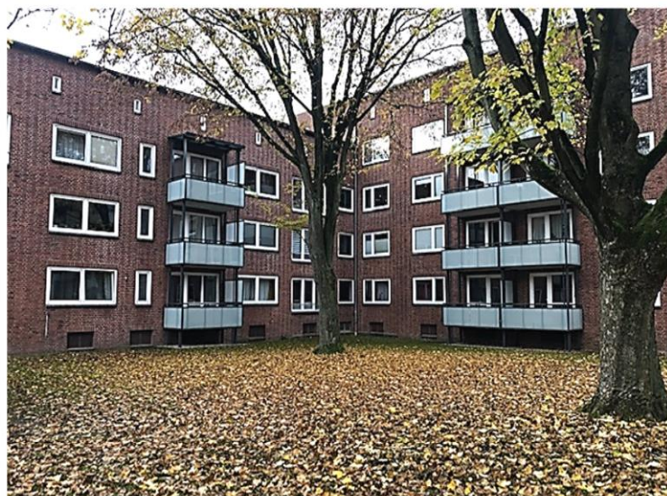
Fertigstellung Modernisierung und Neubau Balkone
