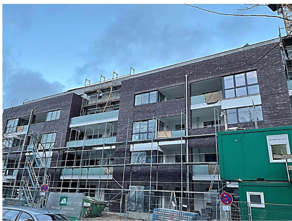
Josephstraße, zweiter Bauabschnitt
