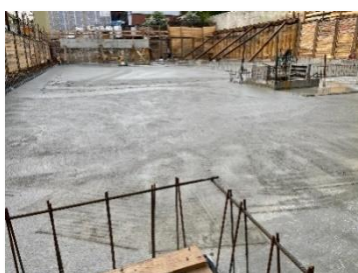
Sohle betoniert, flügelgeglättet, zweiter Bauabschnitt
