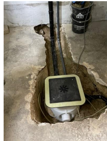
Herstellung der Hochsielleitungen
