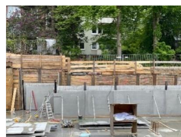
Die ersten Halfertigteile sind gestellt, zweiter Bauabschnitt
