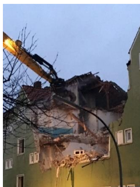
Abbruch Josephstraße, zweiter Bauabschnitt
