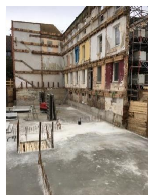
Sohle mit Altbaufassade und Haltegerüst, erster Bauabschnitt
