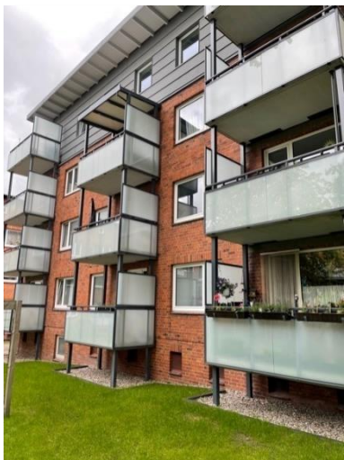
Fertigstellung Balkonanlage und Ausbau Dachgeschosswohnungen Birtstraße
