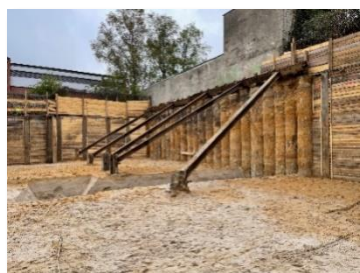
Verbau mit „Totmännern“, zweiter Bauabschnitt
