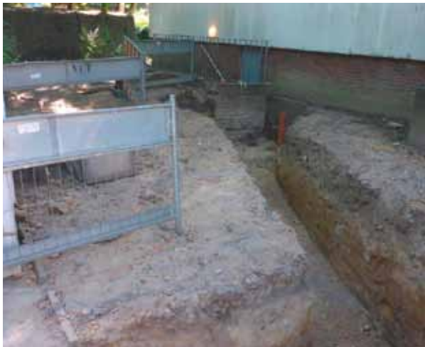
Heizungseinbau Kielkoppelstraße / Geesthachter Kehre Erarbeiten Leitungstrasse
